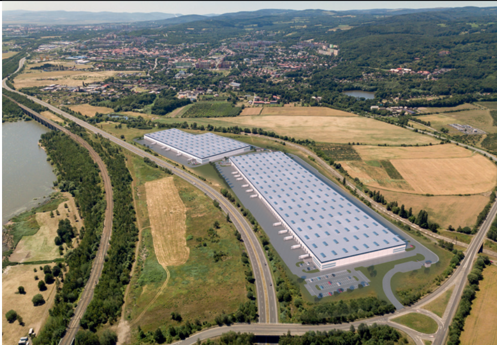
Průmyslový park v Chomutově, který po svém dokončení bude zahrnovat 90 000 m 2 pronajímatelných prostor, přilákal německého výrobce Jungheinrich a americký Amazon. Další průmyslový park chystá investiční skupina RSJ spolu s developerem Panattoni v Hradci Králové
