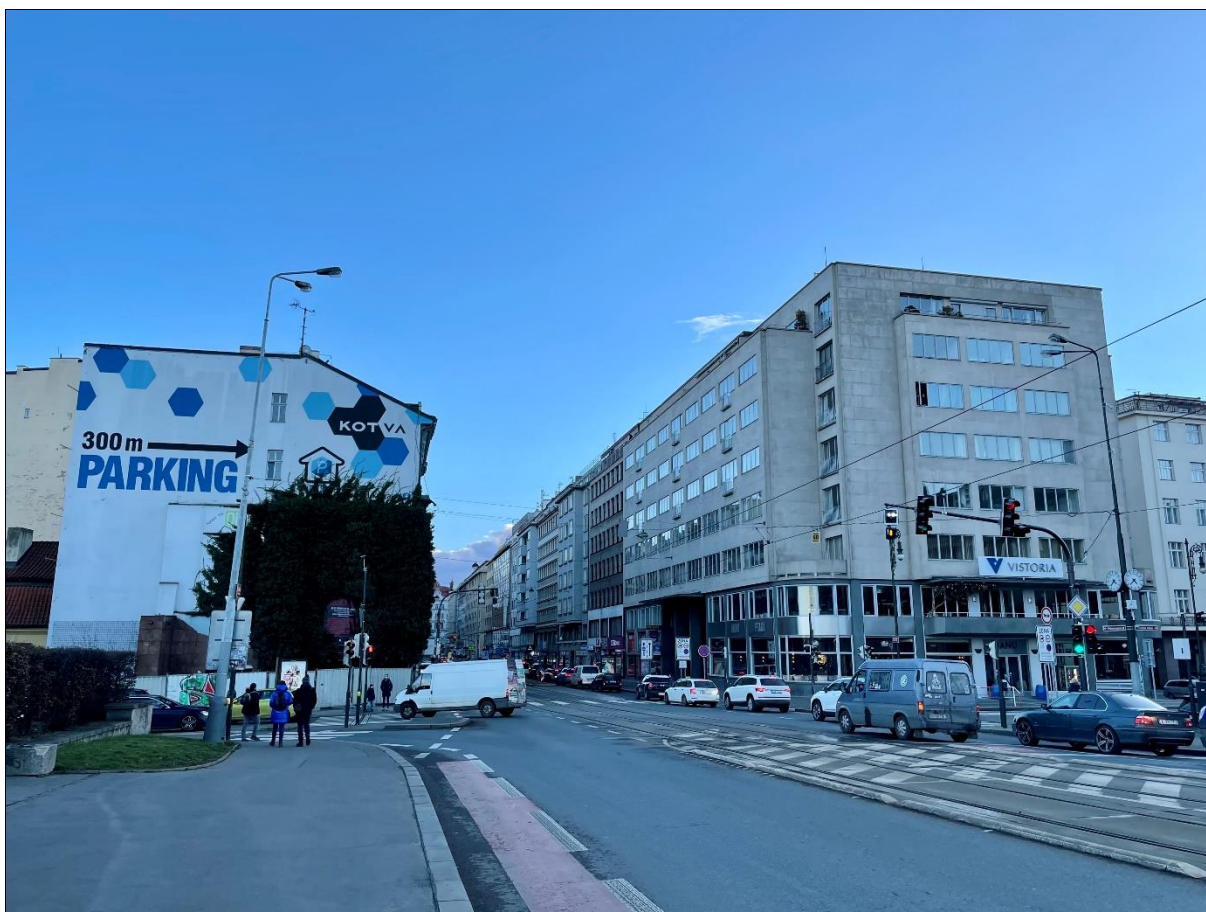
Pohled od Štefánikova mostu na slepou štítovou zeď domu č.p. 1502, která byla doposud využívaná jako reklamní plocha.
